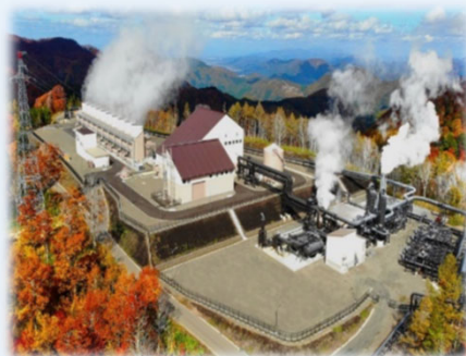
○秋田県湯沢市 山葵沢地熱発電所
